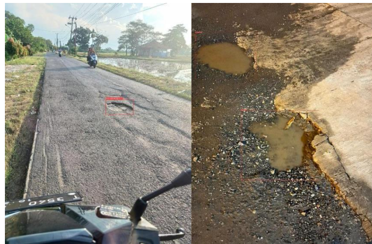
Gambar 10. Hasil Deteksi Jalan Berlubang Menggunakan Kamera Smartphone
